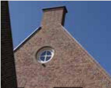
Schoorsteen als tuit van tuitgevel
